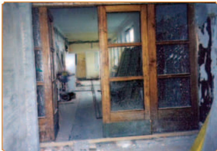
Začetki obnove šole avgusta 2000 (foto: M. Marn)
