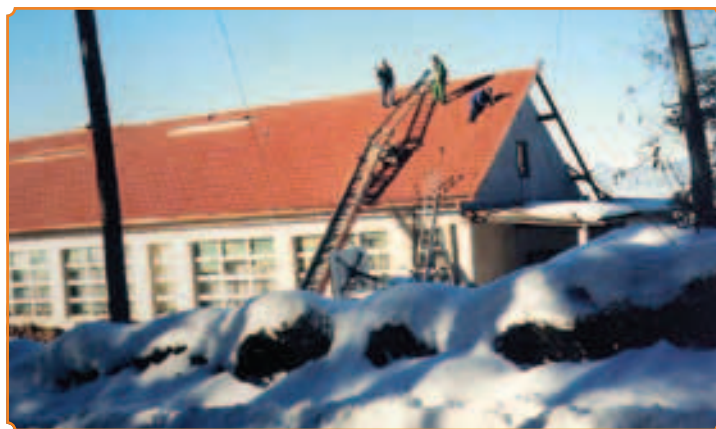
Obnova strešne kritine na šolski zgradbi (foto: M. Marn)
