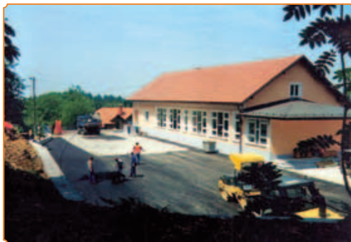
Asfaltiranje dvorišča in igrišča, junij 2001 (foto: M. Marn)
