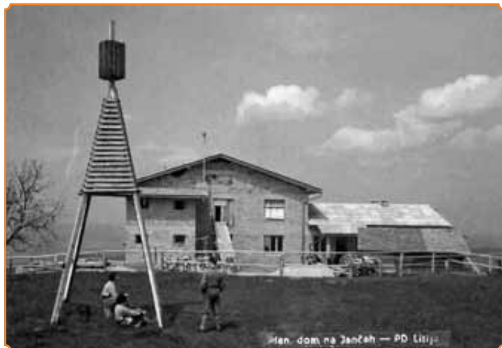
Planinski dom v izgradnji leta 1956 (fotografija last J. Končarja)
