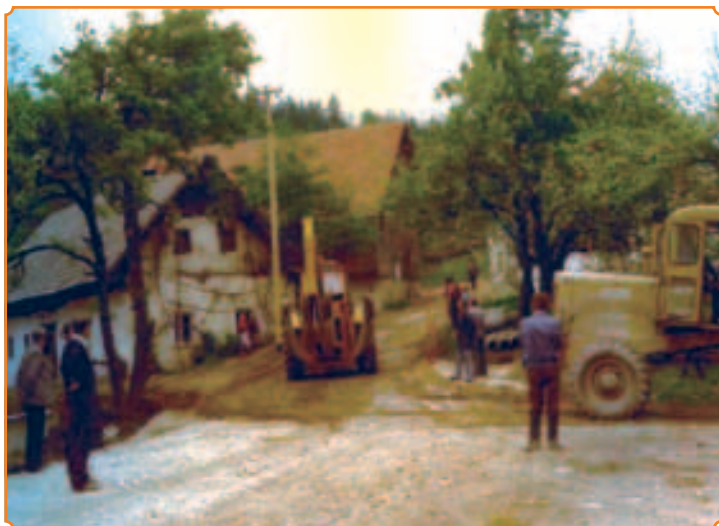
Rekonstrukcija cestišča skozi vas Gabrje (fotodokumentacija: J. Končar)
